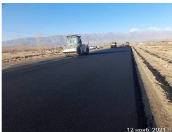
Фото 12. Нижний слой асфальтобетона на км 8+845-9+269 LHS
