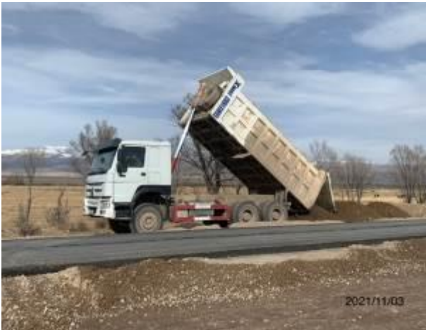
Фото 22. Насыпь обочины дороги на км.
