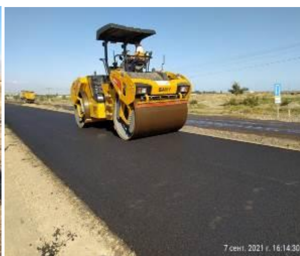
Фото 13. Уплотнение асфальтового основания км 3+140-км3+700
