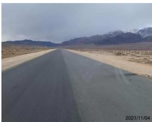
Фото 14. Нижний слой а/б покрытия 9 см на участке км 3+140-км7+000
