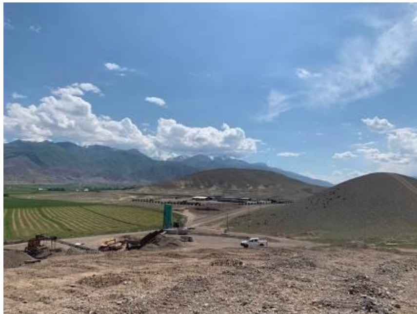
Фото 43. Месторасположение производственной базы ДСУ на первом плане и на заднем лагерь Подрядчика.
