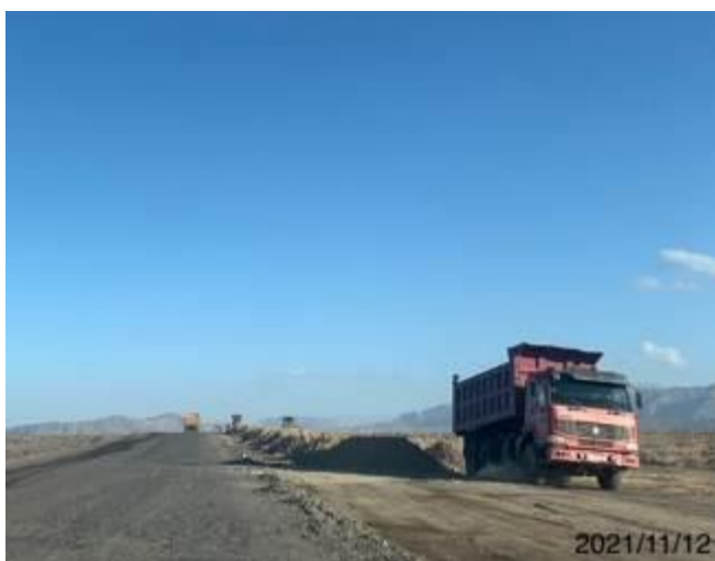
Фото 10. Устройство подстилающего слоя на км 24+260-24+700
