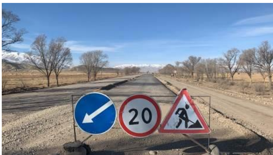
Фото 19. Участок после уширения и формирования зем.полотна км 78+840
