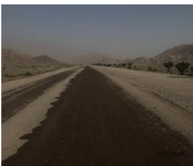
Фото 89, 90. Гидроорошение грунтового дорожного полотна на Лот 1.
