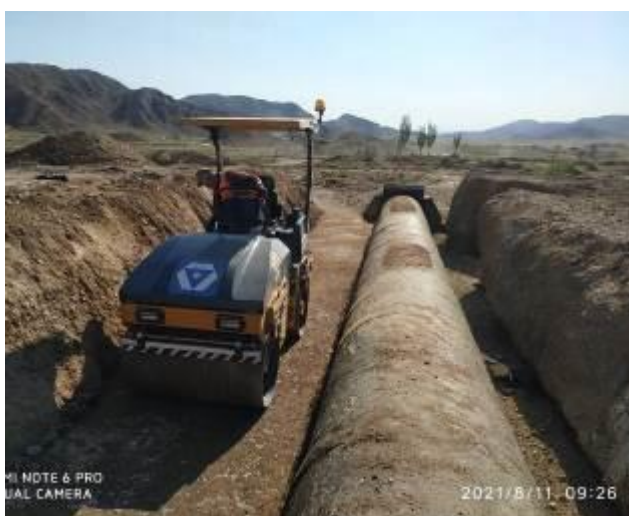
Фото 15. Уплотнение грунта обратной засыпки водопропускной трубы на км 20+670
