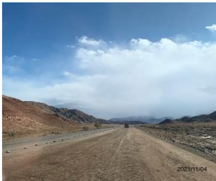
Фото 2. Уширение дороги на участке км. 17+500 – 18+500: после расчистки и корчевания.
