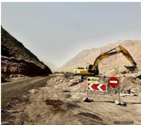
Фото 16. Обратная засыпка трубы на км 16+150
