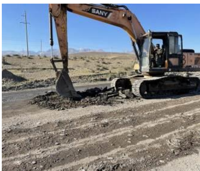
Фото 20. Кирровка существующего асфальтового покрытия на км. 81+460-81+500
