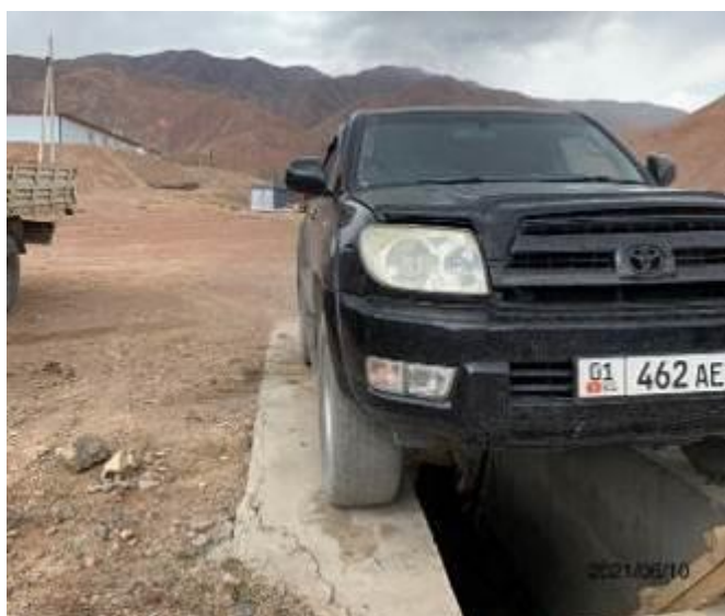
Фото 52. Смотровая яма под открытым небом
