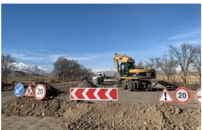
Фото 31. Установка оголовков км 78+772
