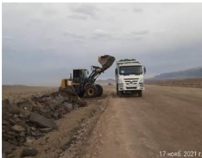
Фото 5. Кирковка и вывоз старого асфальтобетона на км.28+200-28+700 RHS
