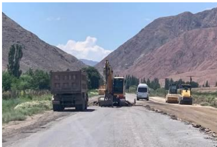
Фото 2. Уширение дороги на участке км. 17+500 – 18+500: после расчистки и корчевания.
