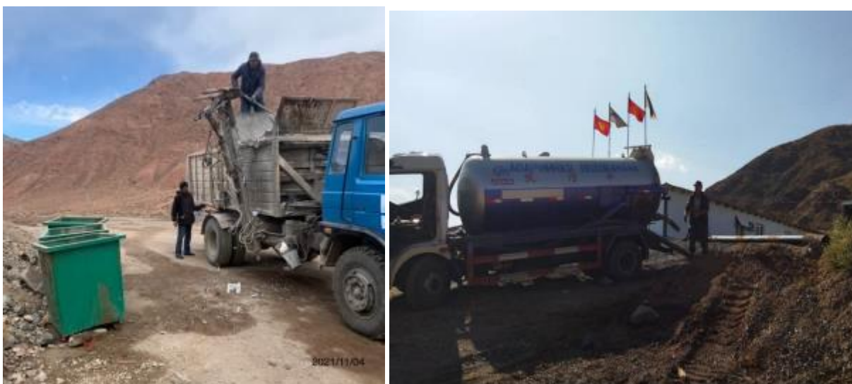
Фото 71. Вывоз ТБО и фото 72 вывоз сточных вод с производственной базы Лот 1.
