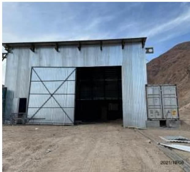
Фото 53. Бокс для ремонта машин и рядом контейнер для складирования отработанных масел
