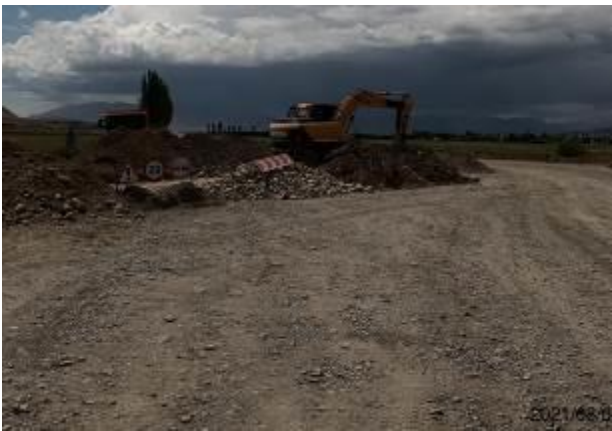
Фото 30. Обратная засыпка в/пр трубы км 80+100
