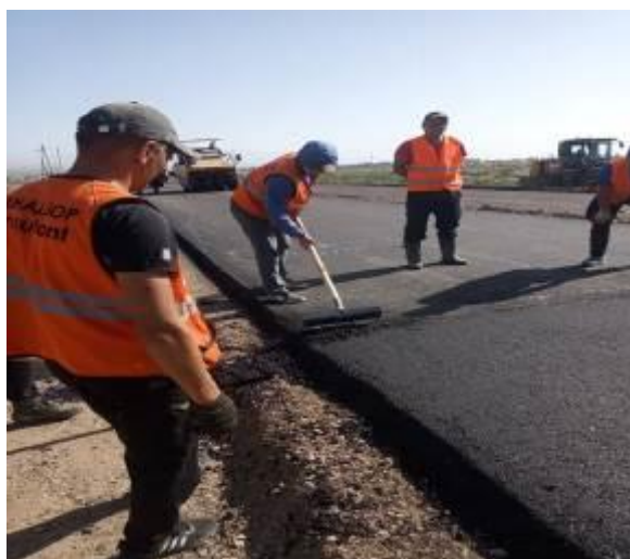
Фото 11. Укладка асфальтобетона на участке км 3+140 - км 5+000
