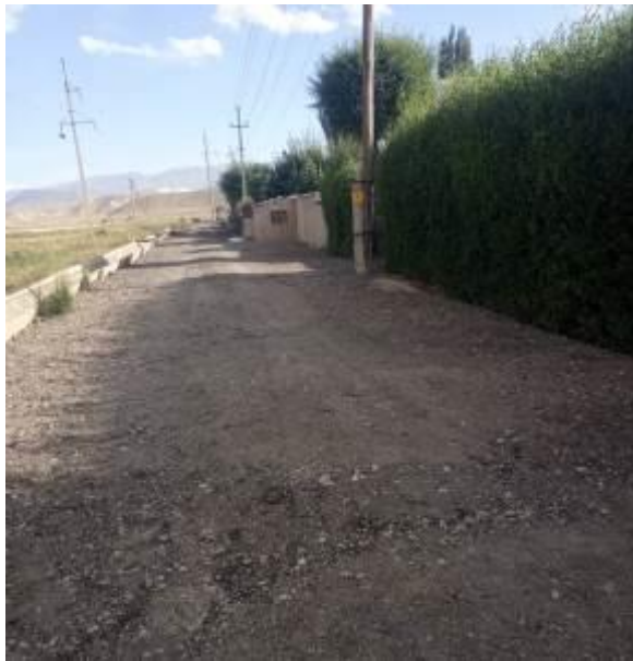
Фото 81, 82. Обустройство периферийной улицы старым асфальтом (укладка и разравнивание) с.Чолпон
