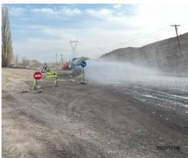
Фото 89, 90. Гидроорошение грунтового дорожного полотна на Лот 1.
