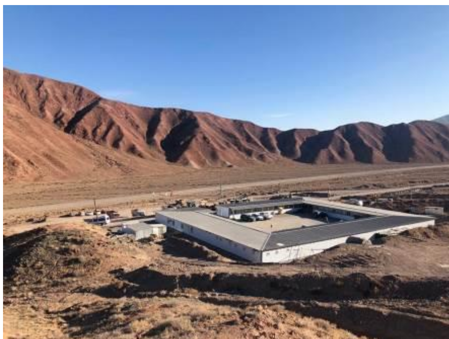
Фото 34. Месторасположение Лагеря строителей, км 16+100
