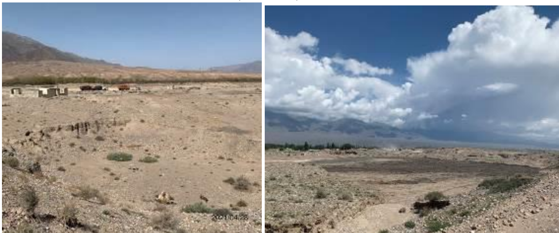
Фото 79, 80. Отвал старого асфальтобетона на км. 7+100 слева до начала размещения (апрель 2021 г.) и справа после завершения размещения старого асфальта (август 2021 г.)
