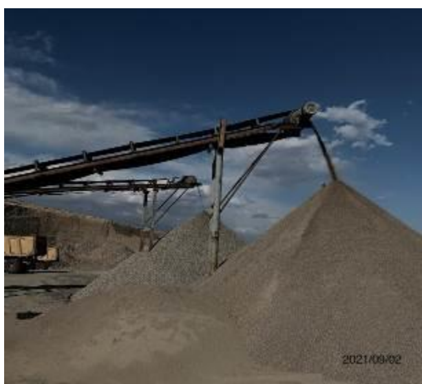
Фото 91. Работа ДСУ на Лот 2.
