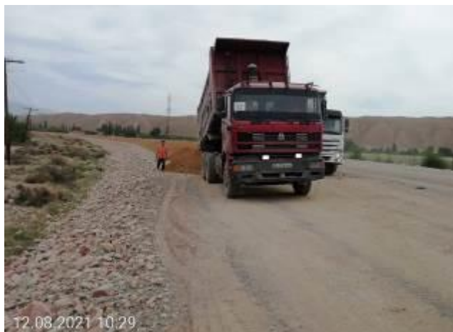
Фото 9. Устройство подстилающего слоя на км 10+100-10+600
