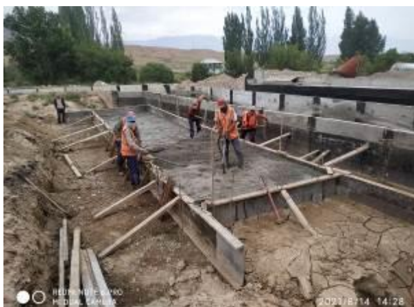
Фото 17. Обвязка стальной балкой берегового устоя моста на км 12+063
