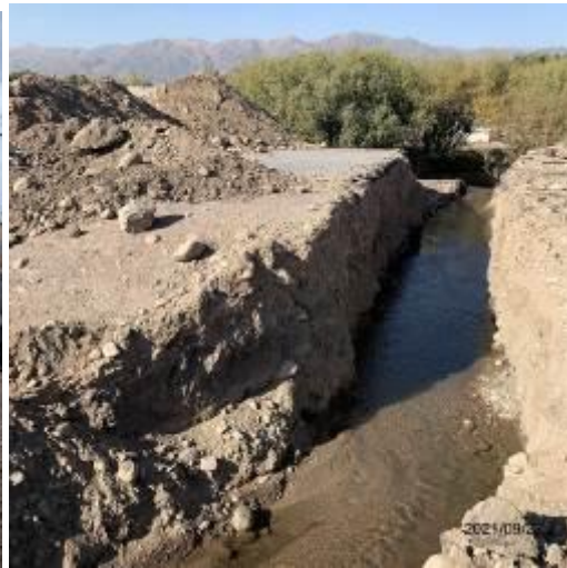
Фото 94. Лот 2. Водоотвод с участка устройства новых водопропускных сооружений км 86+220.
