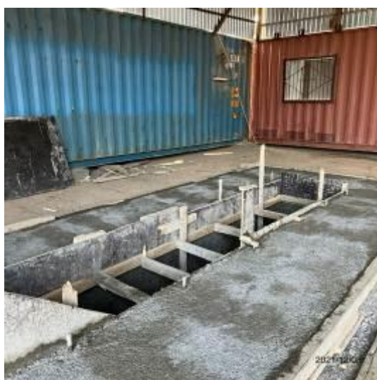
Фото 54. Бетонированная смотровая яма внутри бокса.
