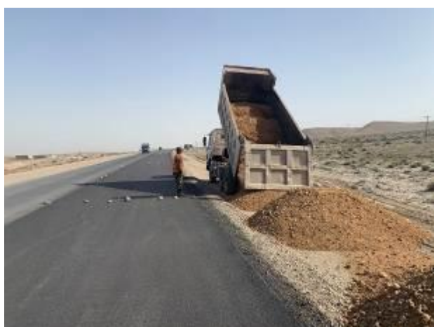
Фото 8. Зем.работы по устройству насыпи обочины дороги на км. 7+350
