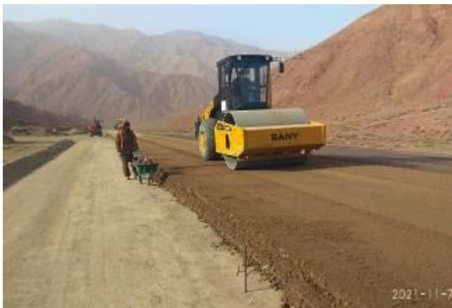
Фото 7. Уплотнение на км 12+300 – км 15+750
