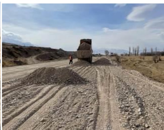
Фото 27. Работы по укладке подстилающего слоя основы на км 80+660 - 81+260
