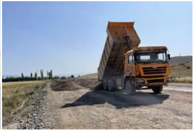
Фото 29. Подготовка материала подстилающего слоя на км 81+720-км 82+300
