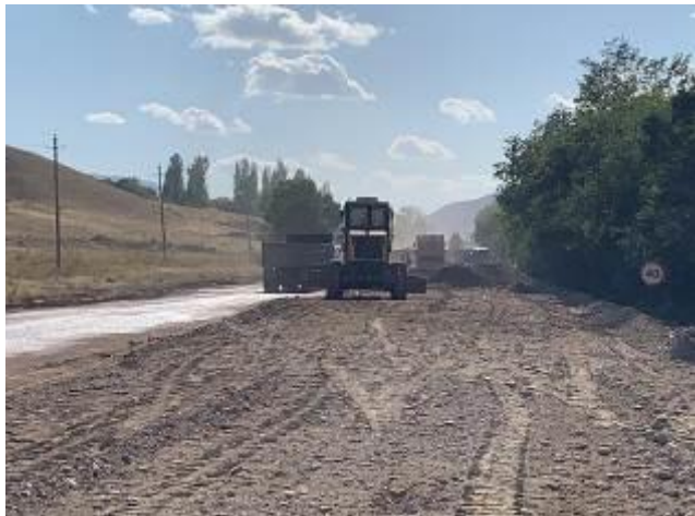
Фото 23. Земляные работы на км.85+430
