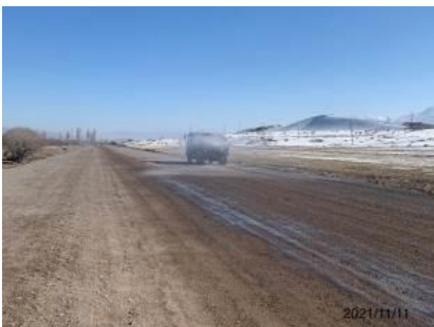
Фото 84, 85. Гидроорошение грунтовых участков дороги на Лот 2.
