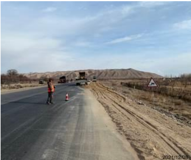
Фото 24. Устройство насыпи обочины
