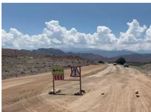
Фото 6. Уплотнение грунта зем.полотна на км. 7+800
