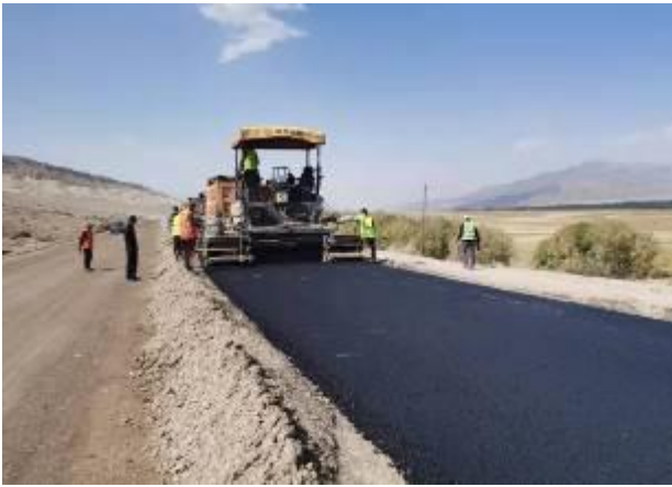
Фото 28. Укладка асфальтового основания на км71+880-72+640 (правая сторона)
