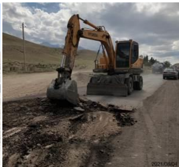
Фото 21. Кирровка существующего асфальтового покрытия на км. 74+550
