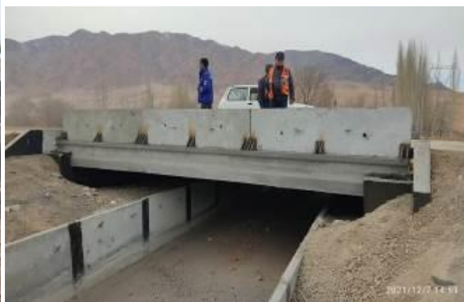
Фото 18. Строительство моста завершено
