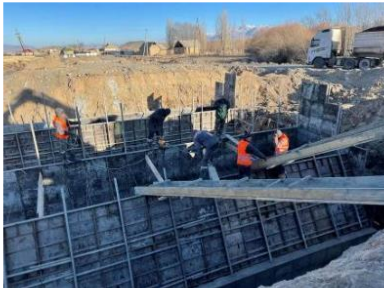
Фото 32. Заливка берегового устоя моста на км 88+795
