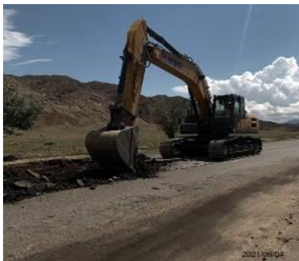
Фото 4. Кирковка старого асфальта на км 17+500
