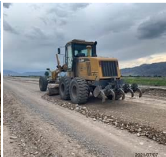
Фото 25. Выравнивание слоя зем.полотна.
